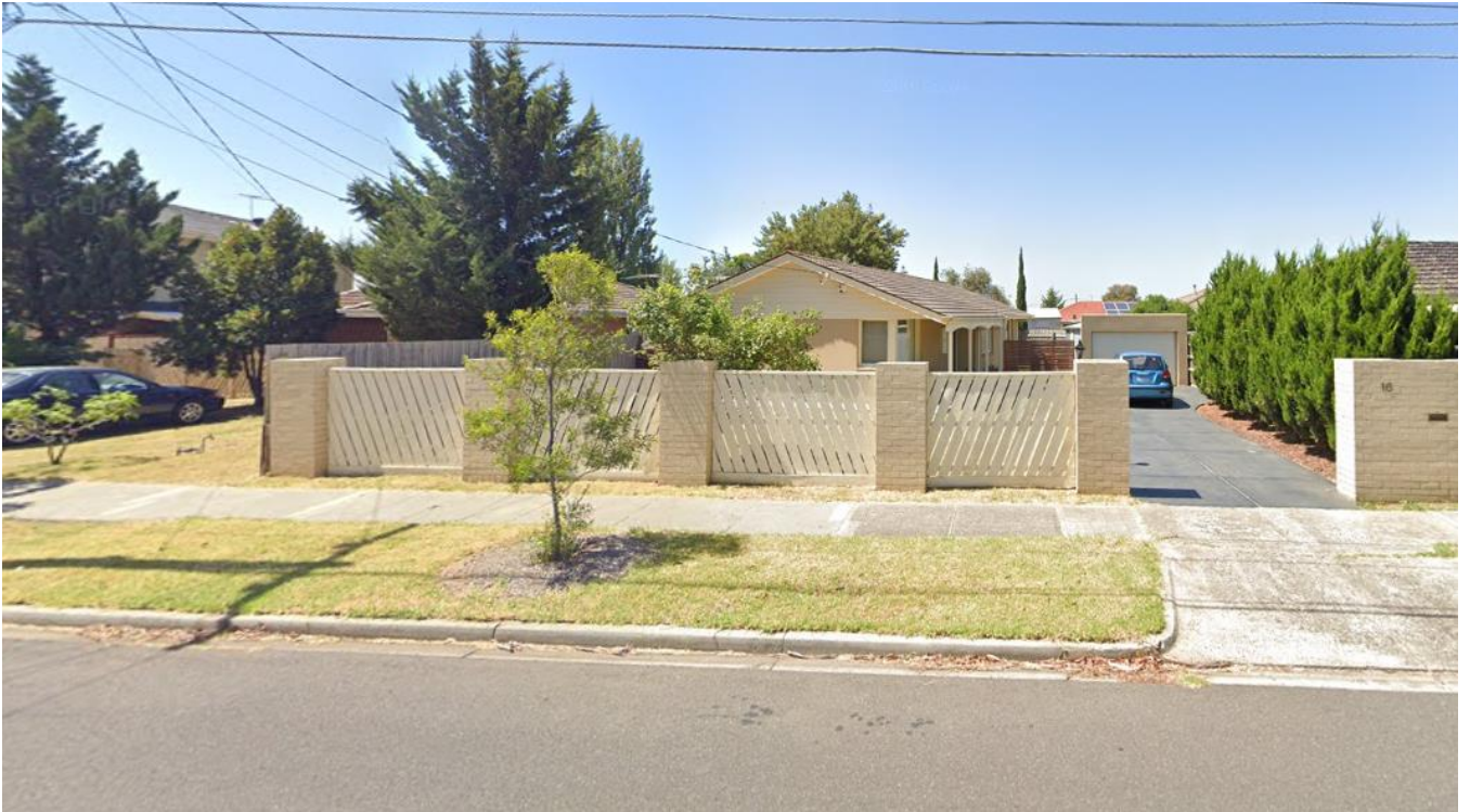
16 Fisher Grove (subject Site)
